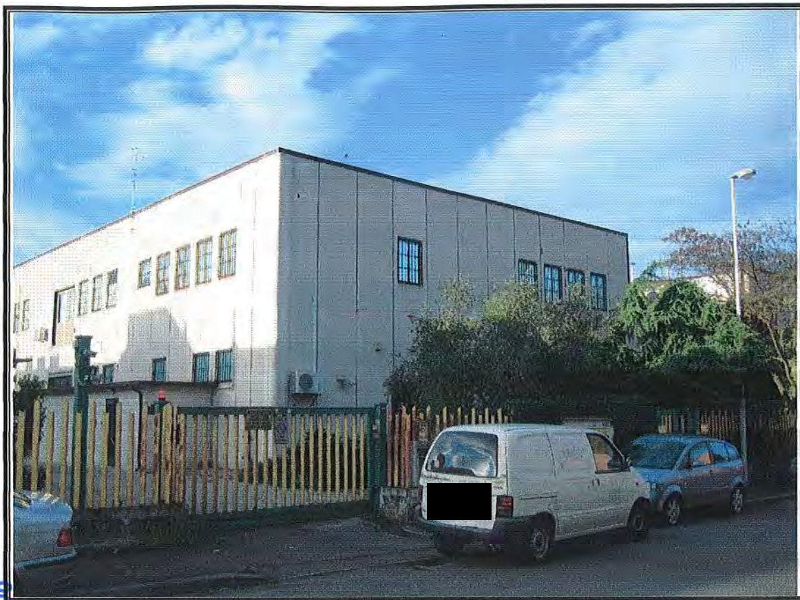
Foto n. 1 – Veduta d'insieme dell'edificio in oggetto e di Via del Gavardello
