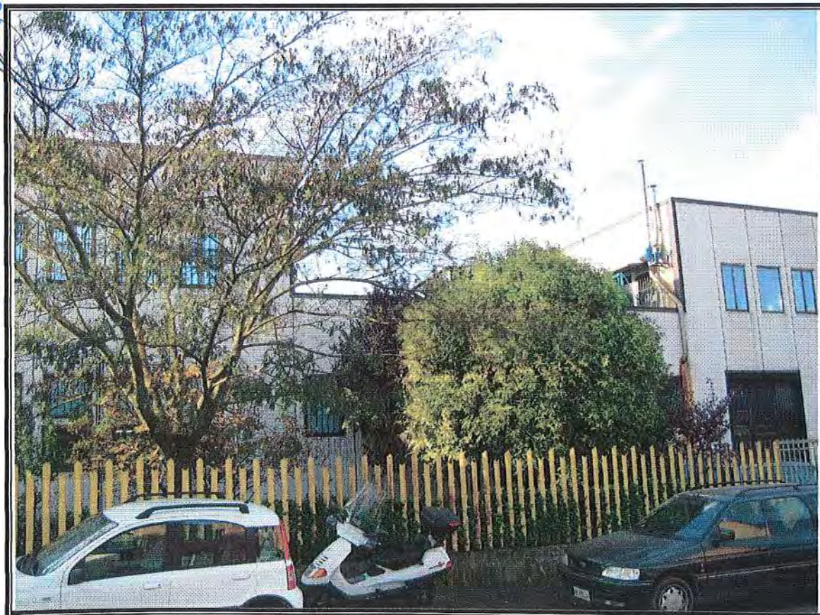
Foto n. 2 – Veduta delle terrazze su cui intervenire.
