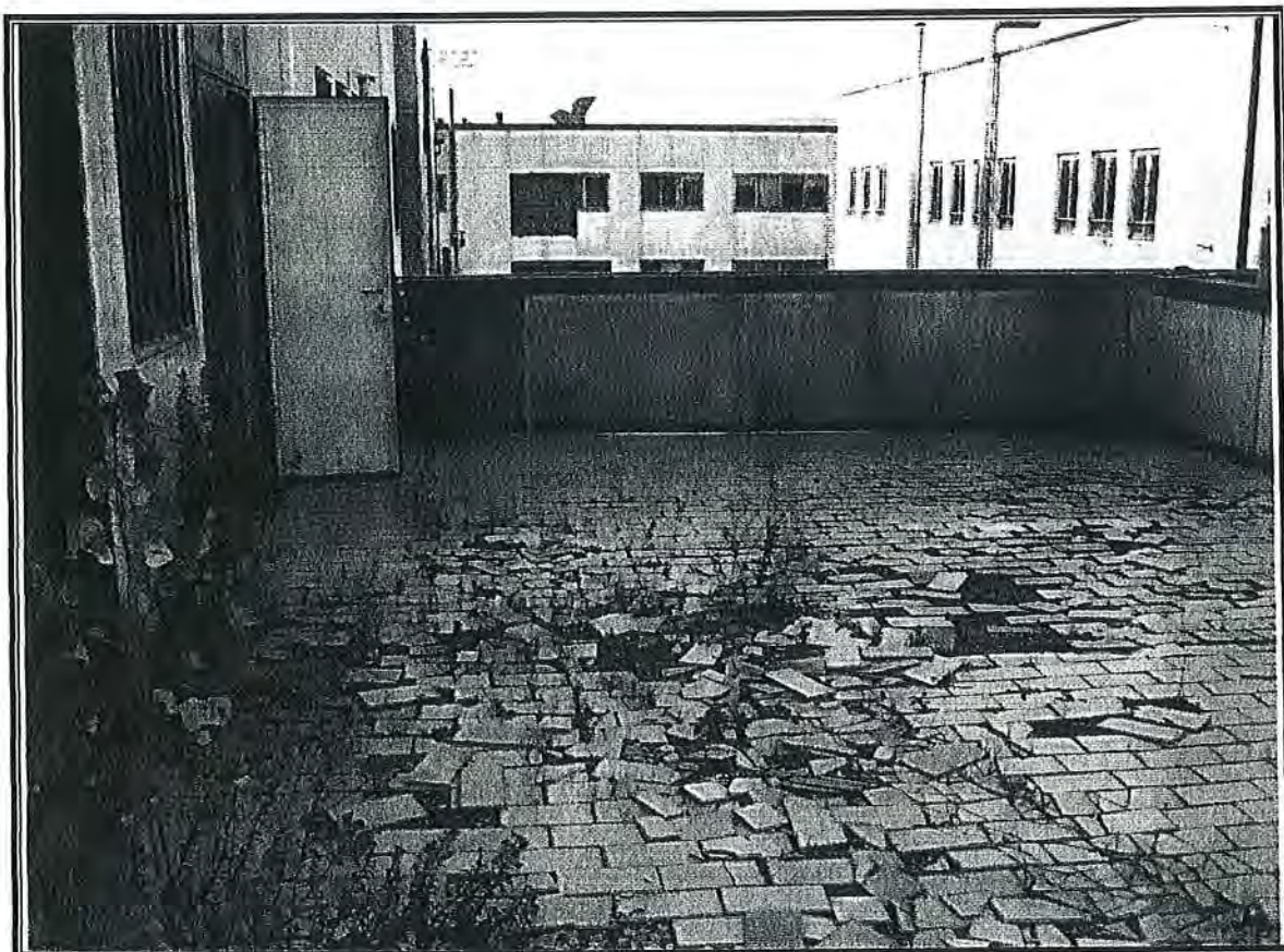
Foto n. 5 –Veduta della terrazza e dell'ingresso sulla stessa dai locali esistenti
