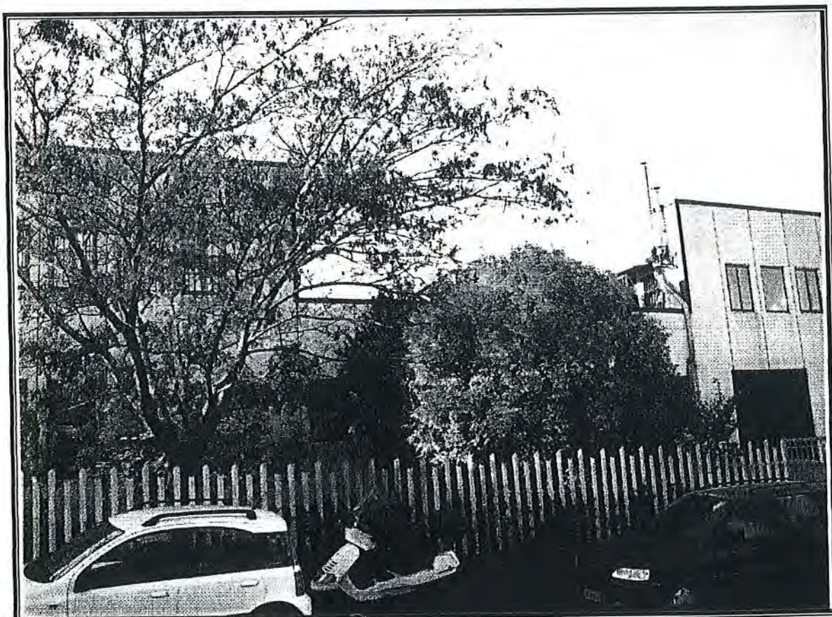
Foto n. 2 – Veduta delle terrazza su cui intervenire.
