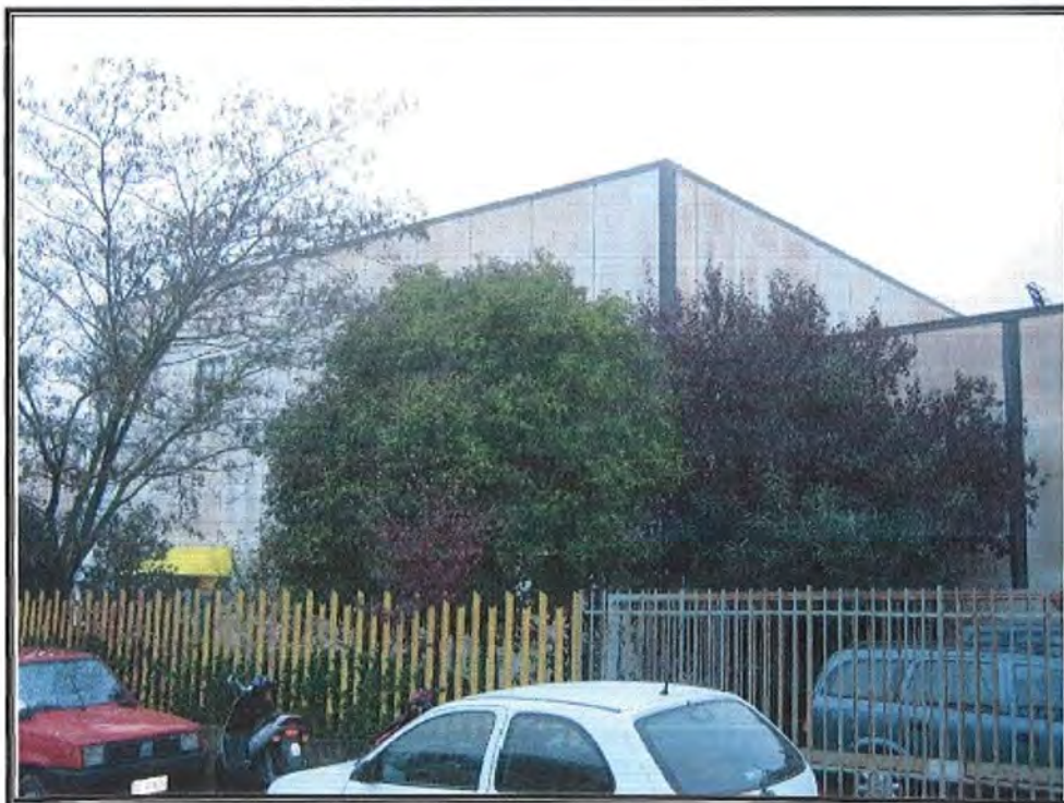
Foto n. 4 – Particolare della terrazza vista da via del Gavardello
