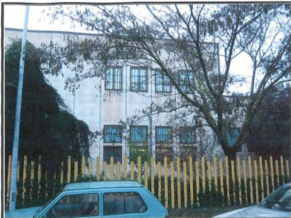
Foto n. 3 – Particolare del prospetto su strada dell'edificio in oggetto
