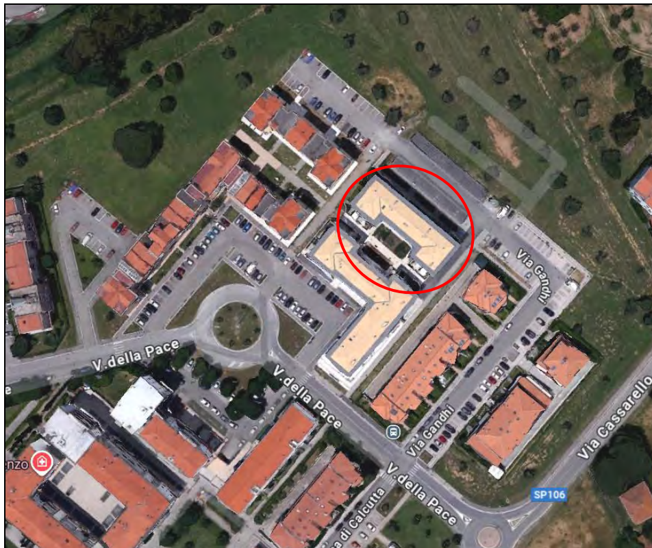
Vista aerea del fabbricato (fonte Google Maps 2025)
